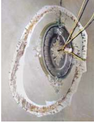
55 | Erdgeschöß, westseitiger Ovalraum (HG 028). Die Freilegung am Plafond des Ovalraumes dokumentiert die Öffnung, durch die der gedeckte Tisch in die „Konspirationstafelstube“ in die Beletage transportiert wurde.
